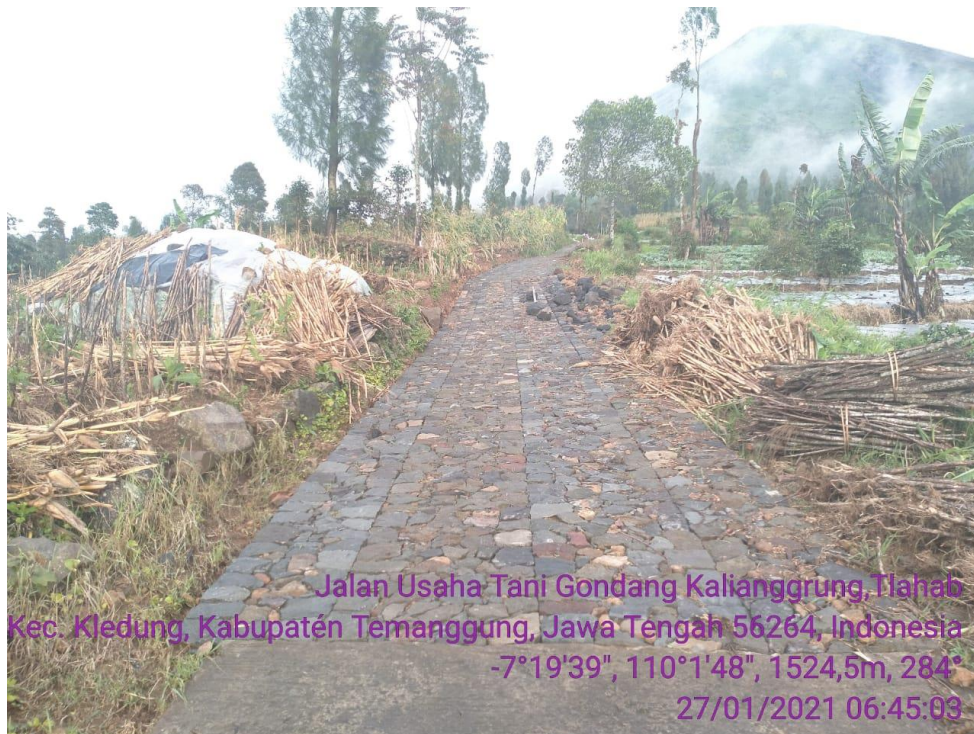
Pembangunan Jalan Usaha Tani Ds.Tlahab – Kledung
