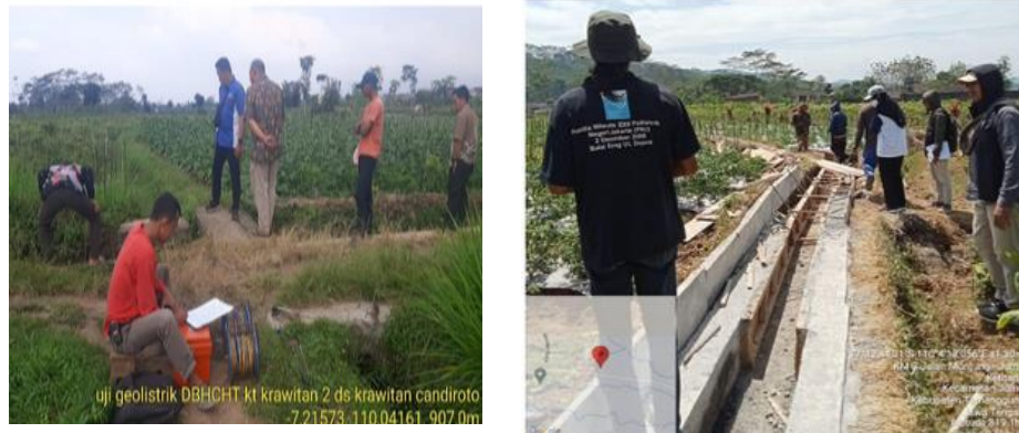
Gambar 3.16. Pembangunan Jaringan irigasi, uji geolistrik, pembangunan irigasi air tanah dalam
