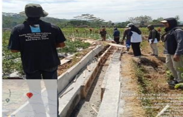
Gambar 3.16. Pembangunan Jaringan irigasi usaha tani
