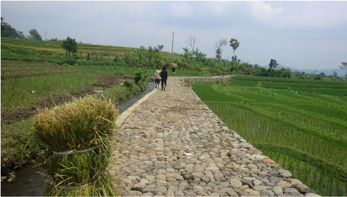
Pembangunan Jalan Usaha Tani
